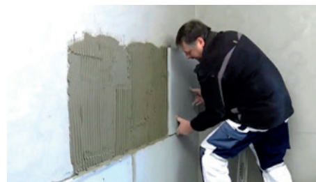
Стена, изолированная плитой SkamoWall 100 мм
